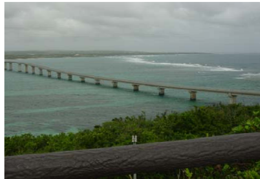
平成9年架設 来間大橋
