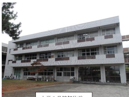
大学2号館解体前
