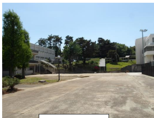
大学2号館解体後
