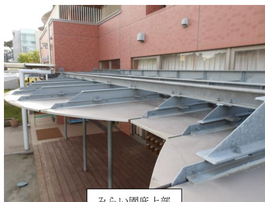
みらい園庇上部
