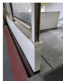
高校 5 号館渡り廊下
