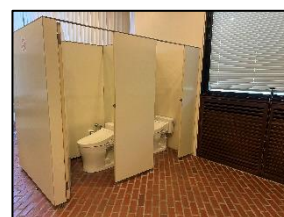
キアラ館トイレ改修
