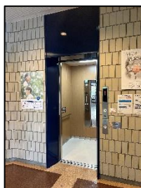
大学3号館エレベーター
