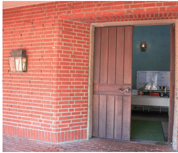
キアラ館 入口
