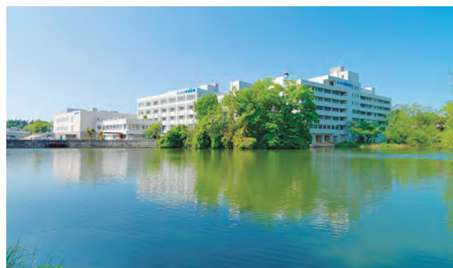
常磐病院外観
